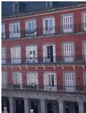
Carpinterías de madera con contraventanas tipo fraileros.
